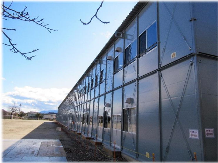
【仮設校舎(外観)】
