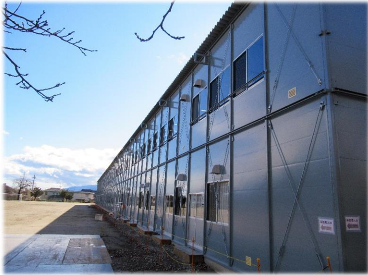
【仮設校舎(外観)】
