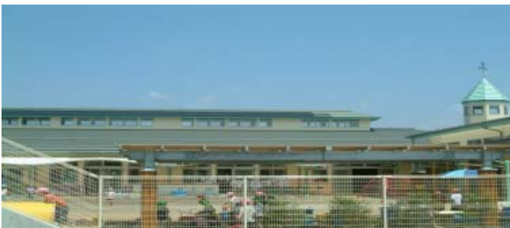
公共施設での太陽光発電システムの設置（みなと保育園）
