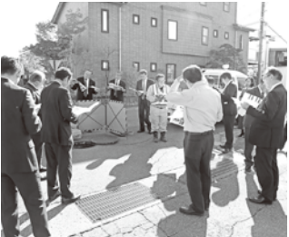
企業会計決算審査にあたり 下水道改築工事を現地視察
