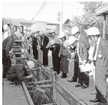
企業会計決算審査にあたり上水道管布設工事を現地視察
