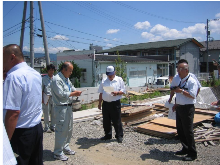
若宮通り線工事現場
