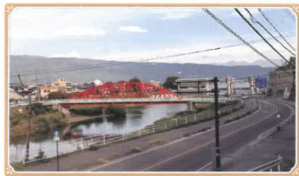
現在の釜口橋 撮影: 議会事務局(令和6年10月)
