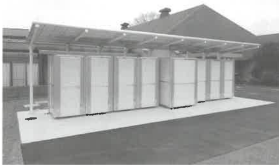
令和5年度に整備した湊小学校のマンホールトイレ
