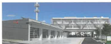
諏訪広域消防本部
