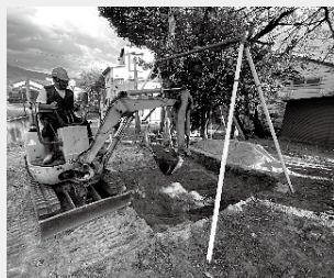
市内遊び場の改修
