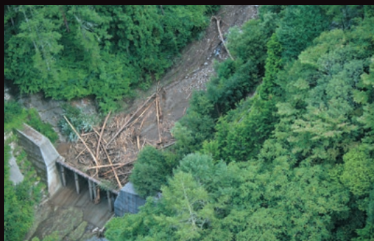
湊 小田井沢砂防えん堤
