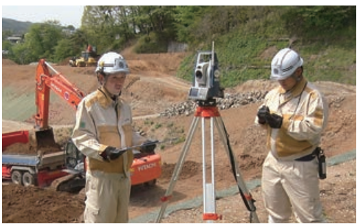
岡谷小学校跡地保全対策工事の現場で
