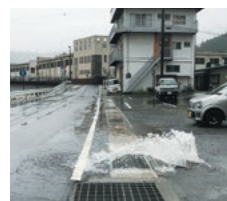
令和3年8月の大雨では、市内でもマンホールからの溢水が数か所ありました。(写真は成田町二丁目付近)
