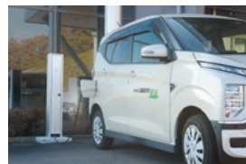
EVカー・充電設備
