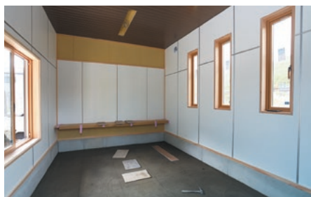
工事中のようす (9月15日撮影)
