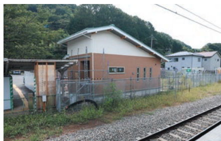
工事中のようす (9月15日撮影)
