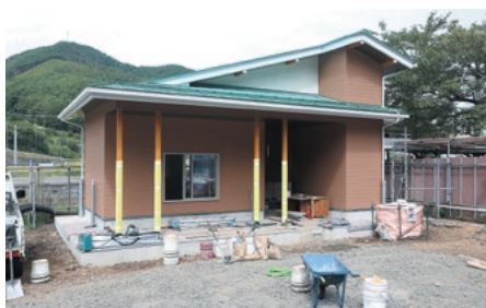
工事中のようす (9月15日撮影)
