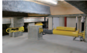
揺れを止めるための制震装置 鋼製ダンパー (左)・油圧ダンパー (右)
