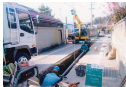
現在の配管工事のようす
