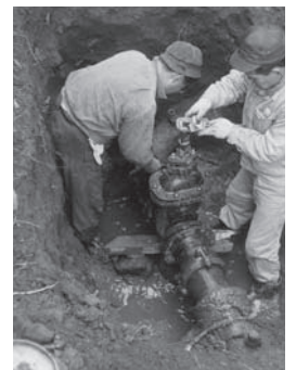
昭和38年の配管工事のようす
