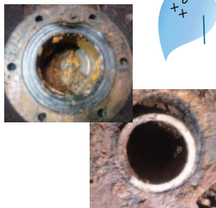
古くなって、さびの出た古い配水管
