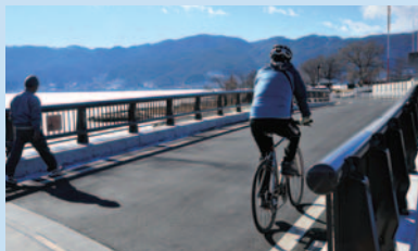
開通した横河川白鳥橋は景観を美しく引き締めている(橋長34.5m、幅員5.5m)
