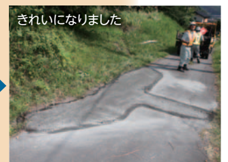
直営補修班のこの日の作業は、亀裂が入ったり崩れたりした路面を修復
