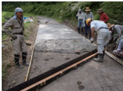
古いコンクリートをはがして整地。メッシュを入れ、水を逃がす水切りも設置し、コンクリートを流す打設まで、本格的な舗装を区民の手で
