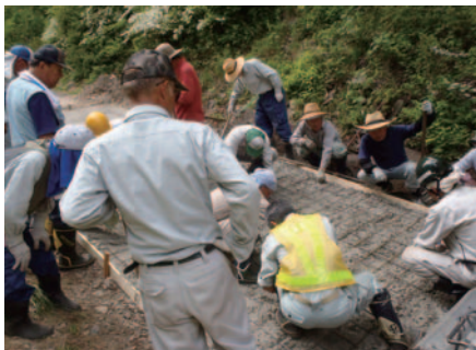
古いコンクリートをはがして整地。メッシュを入れ、水を逃がす水切りも設置し、コンクリートを流す打設まで、本格的な舗装を区民の手で
