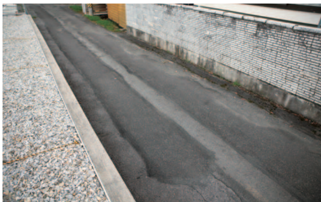
ひび割れ、陥没、傾斜が見られた道路も補修により快適に
