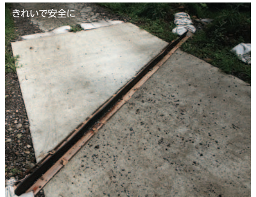
古いコンクリートをはがして整地。メッシュを入れ、水を逃がす水切りも設置し、コンクリートを流す打設まで、本格的な舗装を区民の手で
