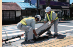
側溝の流路を確認し、ゲリラ豪雨などへの対策を練る
