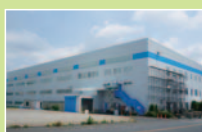
施工イメージ
