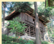
土台足場の中央をくぐって通行
