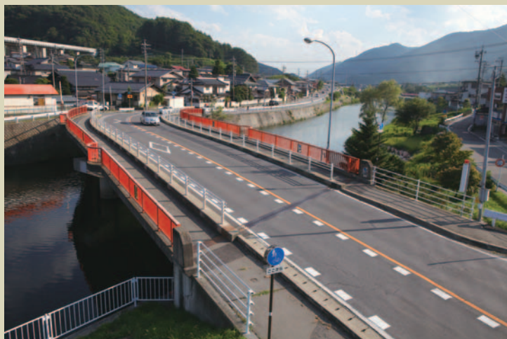
観蜚橋から鮎沢区を望む。橋は美しいS字カーブを描き、取り付け道路の改良によっても渋滞は解消。橋にはホタルとツクサのレリーフや旧橋のイメージを残すバルコニーも
