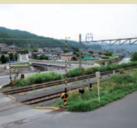
⑨国道20号改良工事
