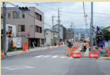
⑩田中線拡幅工事
