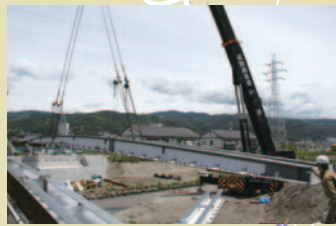
⑤西堀橋架替工事
