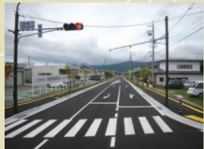
⑫東堀線整備工事
