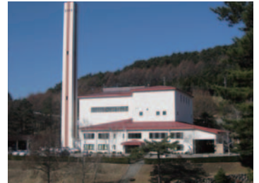
現在の清掃工場(岡谷市内山)
