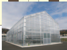
小井川浄水場
