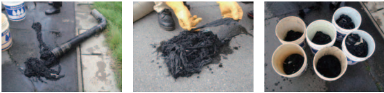
実際にごみがつまった管 布が3、髪の毛などが7の割合 バケツ6個分のごみが!
