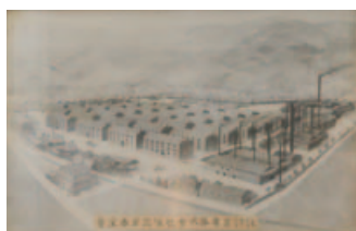
F 諏訪倉庫資料より往時の塚間倉庫群
