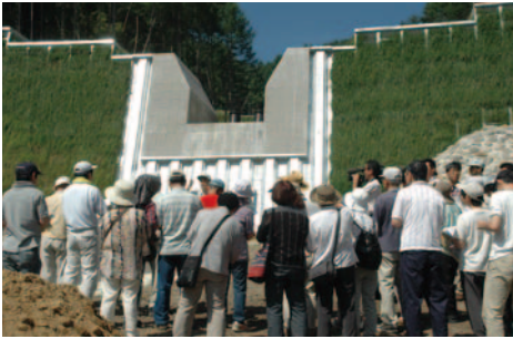
完成した砂防ダムの見学会
