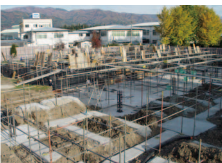
着工された湖北火葬場
