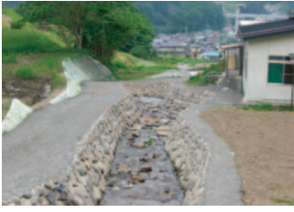
復旧後の現地
