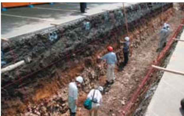
△Bトレンチでの調査の様子
