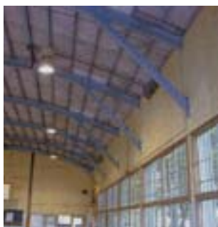
耐震改修工事が施工された川岸小学校第2体育館
