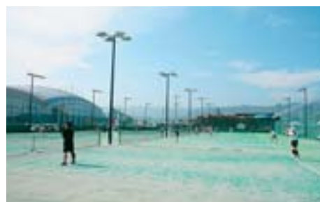
全天候型コートに改修された市営庭球場
