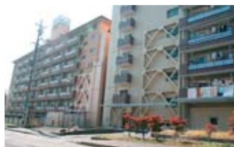
耐震改修工事が施行された加茂団地
