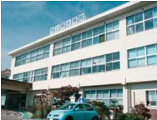
耐震改修工事が施行された岡谷病院
