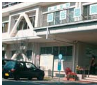
耐震改修工事が施行された 塩嶺病院管理棟
