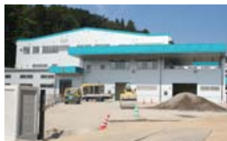
塩嶺林間工業団地に建設中の工場
