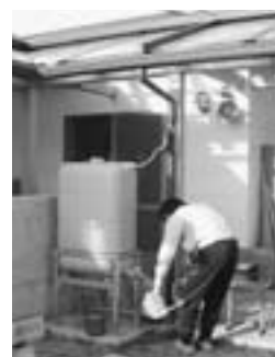
△公共施設への 雨水タンク設置
