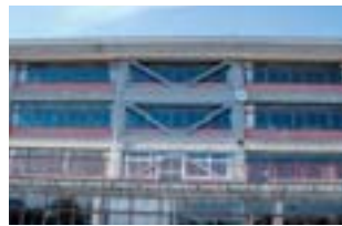
耐震改修後の小井川小学校教室棟
