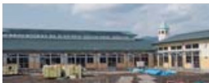
建設中のみなと保育園
