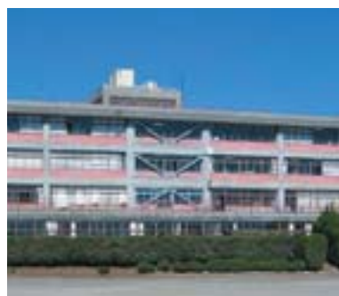
耐震改修工事終了後の 小井川小学校教室棟
