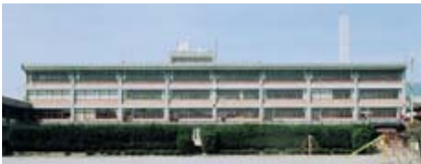
耐震改修を行う小井川業学校教室棟
