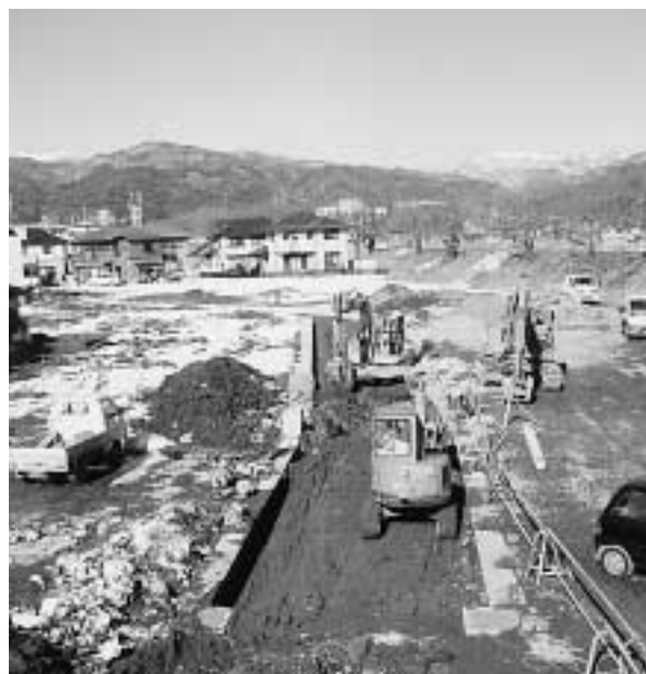
▲工事が進む南宮2丁目宅地分譲地
