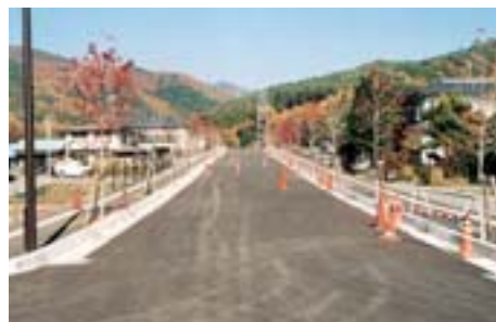
都市計画道路東町線整備事業として、国道20号バイパス～市道長地209号線の第1期事業区間400mを整備しました。国道20号バイパスと同時に供用開始します。
