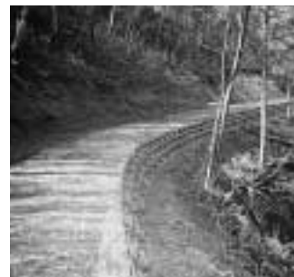
▲作業道に木材を使用
