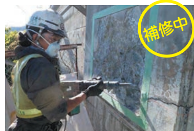
ひび割れ部分の既設コンクリートを削ります
