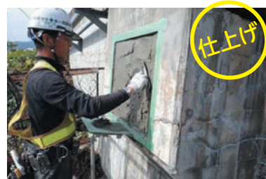
さびを防ぐ薬剤を塗布後、断面を修復します
