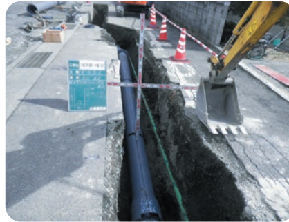
新しい水道管の布設工事のようす
