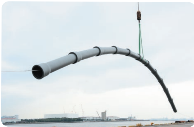
つり上げることで、管のたわみを確認できます
