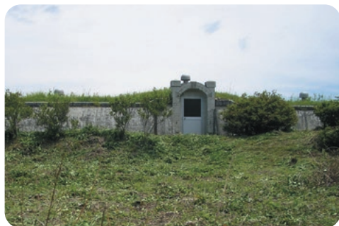
既に廃止された岡谷配水池
