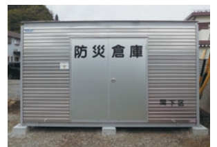
防災倉庫(間下区)
