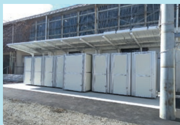
小井川小学校の設置状況
