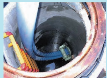
管をマンホールに引き込む
