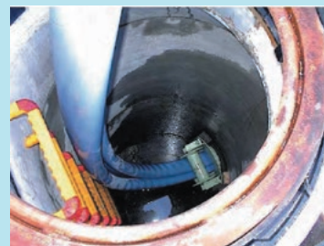
管をマンホールに引き込む
