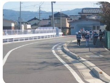
歩道を新設し、安全な歩行空間を確保 (長地135号線)
