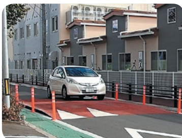
今年度完成予定(103号線：西堀通り線)
