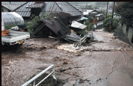
川岸西 須門狭間川溢水
