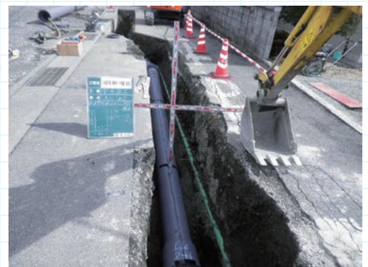
水道管の布設替え工事
