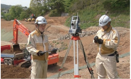
岡谷小学校跡地保全対策工事の現場で
