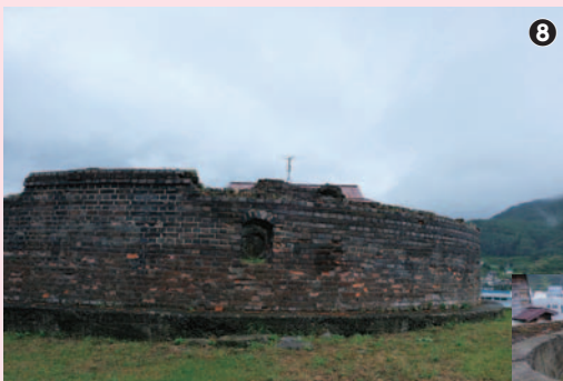
大正3年に造られた、三重構造レンガ造り(内側は粗いコンクリート)のタンク。現在残るのは土台部分のみ。なんとも不思議な雰囲気です
