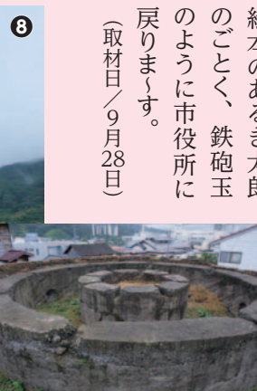
大正3年に造られた、三重構造レンガ造り(内側は粗いコンクリート)のタンク。現在残るのは土台部分のみ。なんとも不思議な雰囲気です
