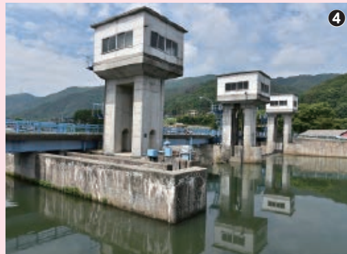
現在の頭首工は1976年の建造。天竜川流域市町村にとって、なくてはならない施設です
