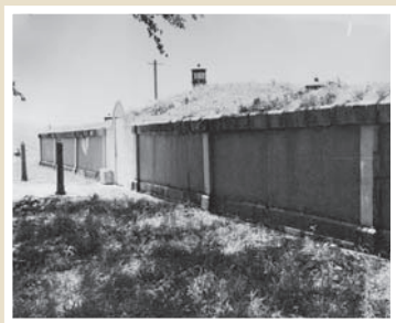
岡谷配水池 (昭和3年建設)
