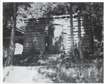
滝ノ沢水源地 (昭和2年建設) 近代化産業遺産
